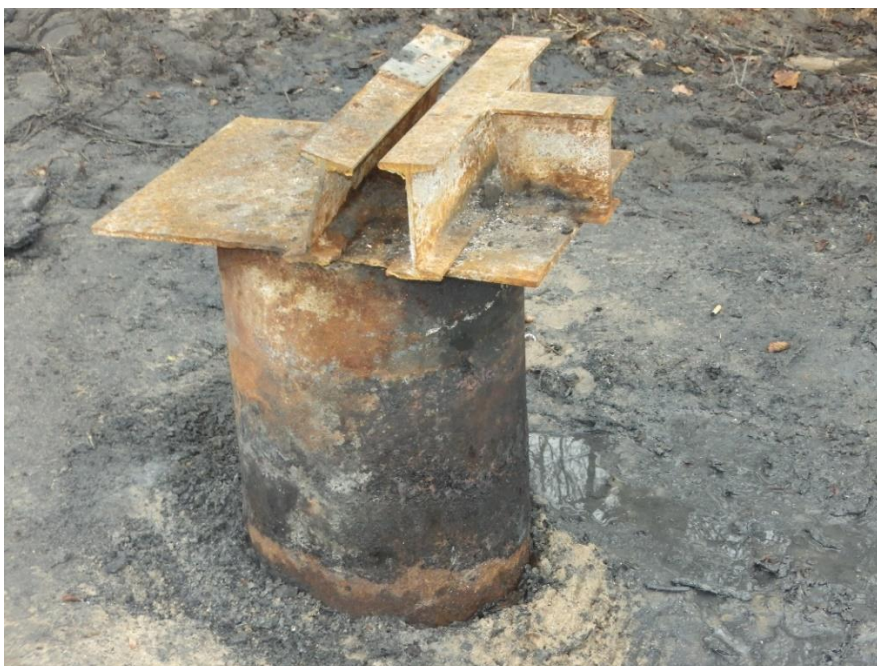
Fot. 10 Widok głowicy pala po demontażu stalowego rusztu pomostu
