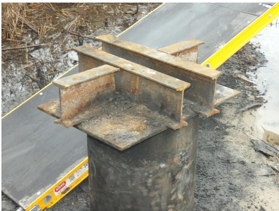
Fot. 9 Widok głowicy pala po demontażu stalowego rusztu pomostu
