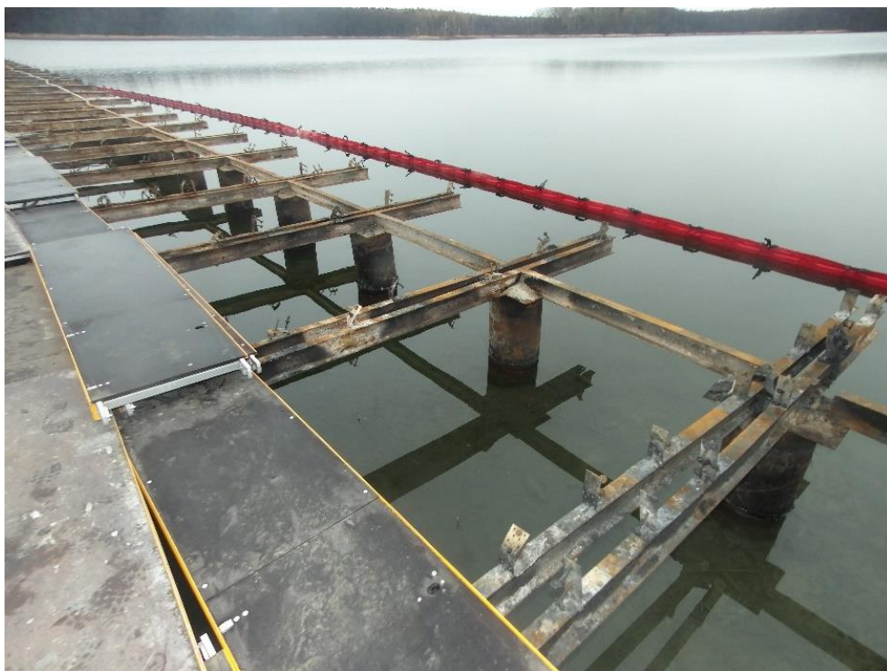
Fot. 4 Widok fragmenty stalowej konstrukcji pomostu, po demontażu spalonego poszycia
