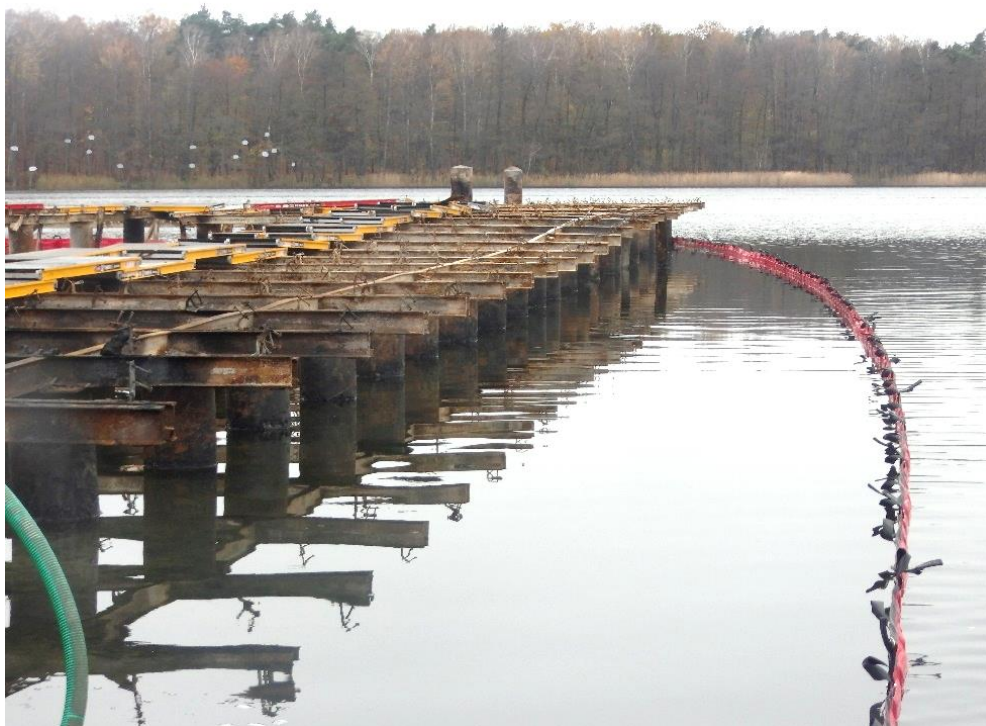
Fot. 3 Widok fragmentu konstrukcji, po spaleniu pomostu
