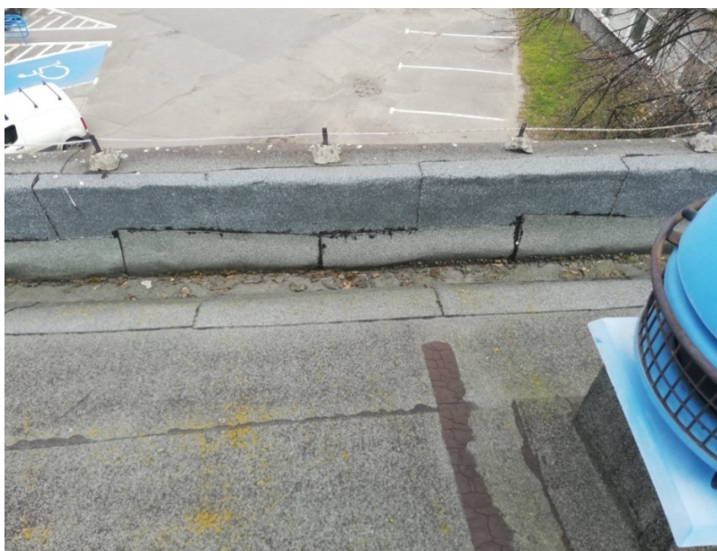
zdjęcie 4 Stan obecny koryta
