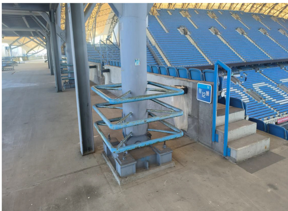
Trybuna IV osłony słupów stalowych. Barierki z rur fi 7 cm w ilości: 12 szt x 15,6 m = 187,2 mb rury
