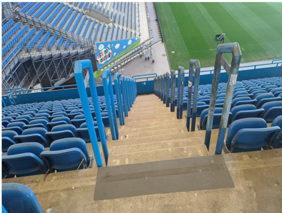
Trybuna IV dokończenie malowania barierek rzędowych z rur fi 7 cm w osiach -2-7 w ilości 96 szt x 2,5 m = 240 mb rury
