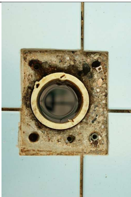
Nieszczelności plaży basenowej
