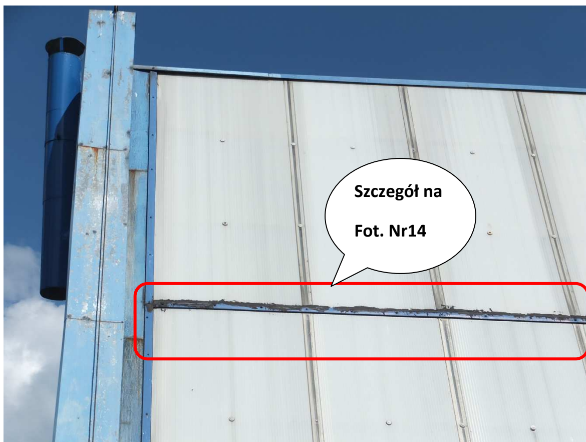
Fot. Nr13 (płyty poliwęglanowe połączone na styk i nakryte od góry listwą metalową)
