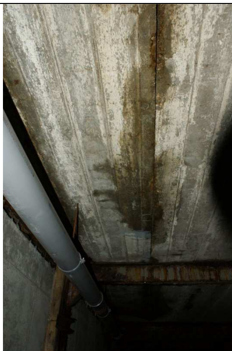
Nieszczelności plaży basenowej
