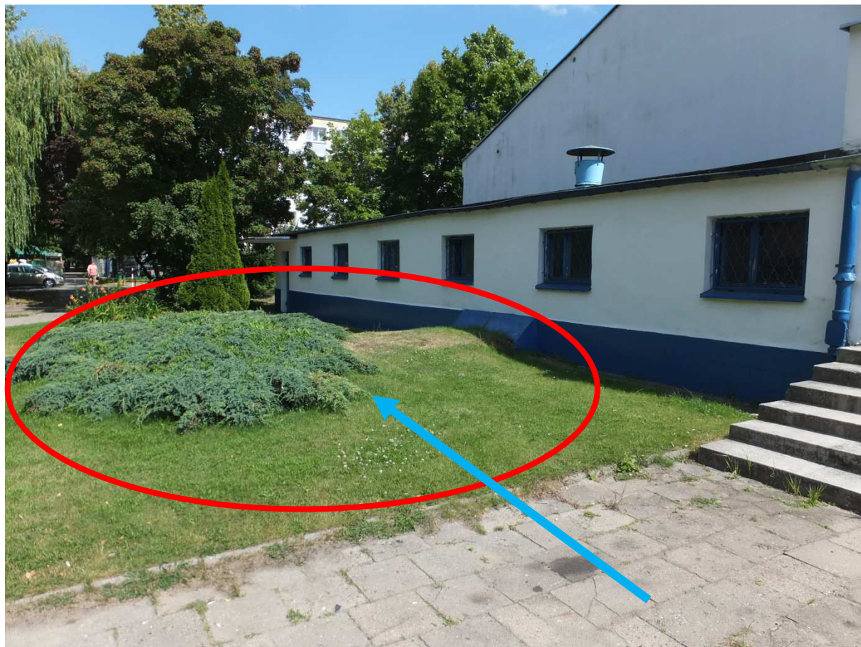
Fot. Nr20 ( zasypana i nieczynna czerpnia powietrza)
