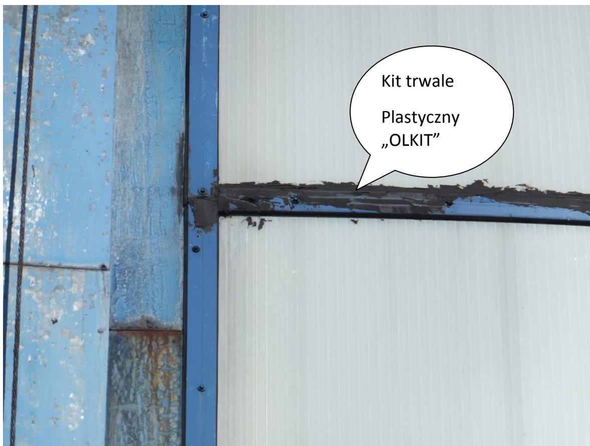
Fot. Nr14 (płyty poliwęglanowe połączone na styk, uszczelnione kitem trwale plastycznym "OLKIT")
