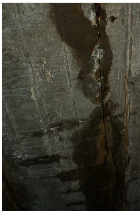
Nieszczelności plaży basenowej
