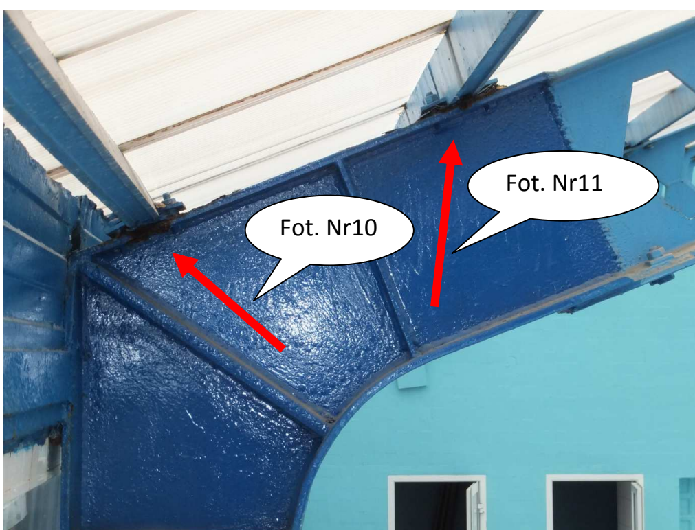
Fot. Nr9 (naroże niższej części ramy konstrukcji nośnej przekrycia pływalni – czerwone strzałki pokazują punktowe zaawansowane ogniska korozji)
