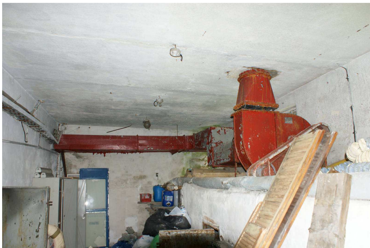
Fot. Nr19 (stropodach nad segmentem socjalno-gospodarczym)
