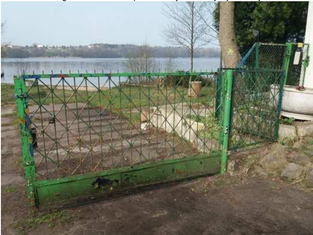
Ogrodzenie: furka i prawe skrzydło bramy wjazdowej
