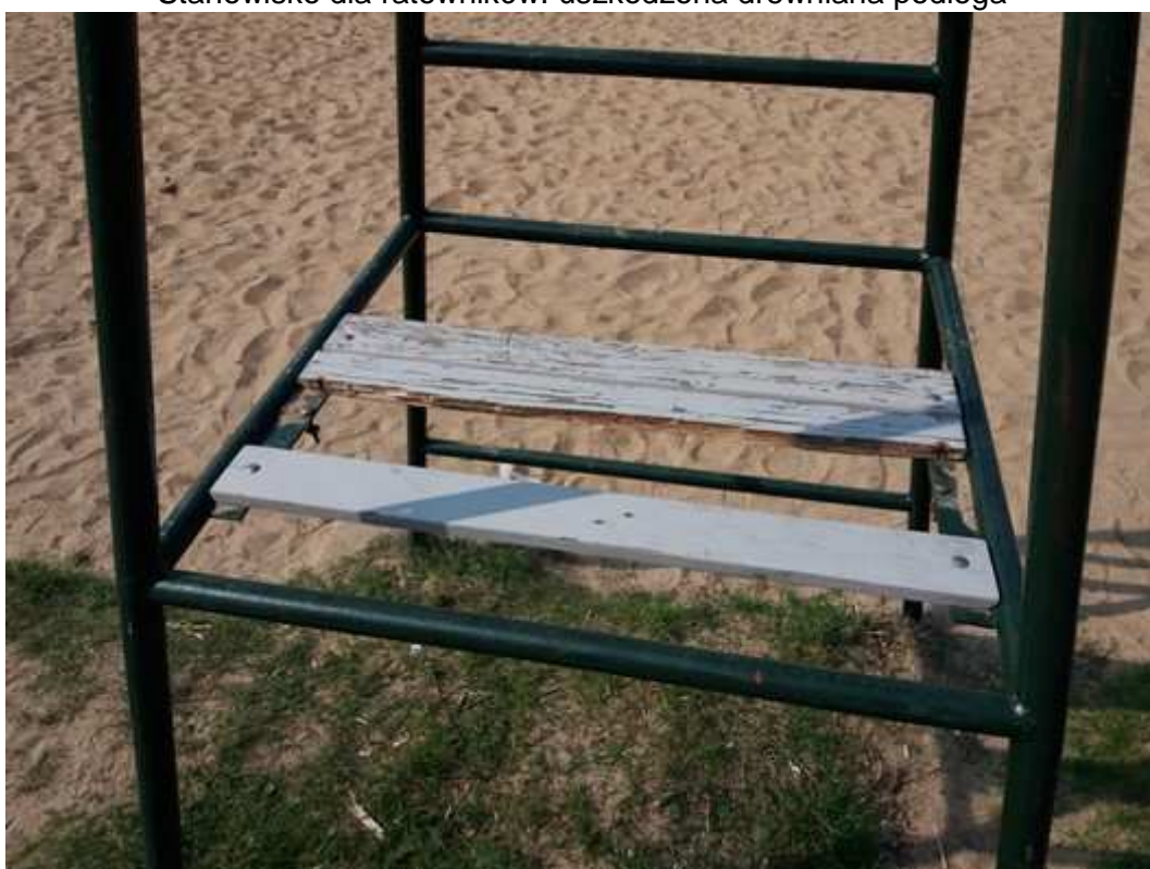
Stanowisko dla ratowników: uszkodzona drewniana podłoga
