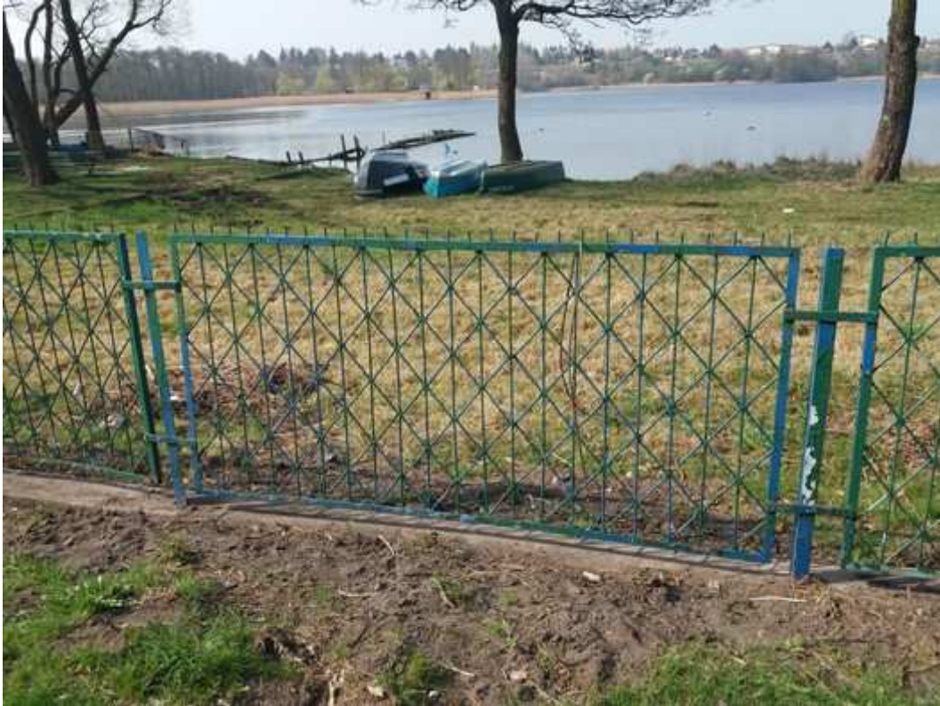
Ogrodzenie: słupki i przęsła stalowe
