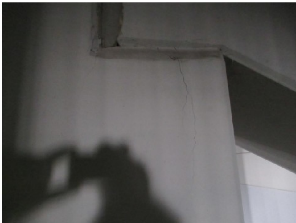
Fot. 32 - 2018 r. - nie stwierdzono poszerzenia rysy. Zalecana dalsza obserwacja.
