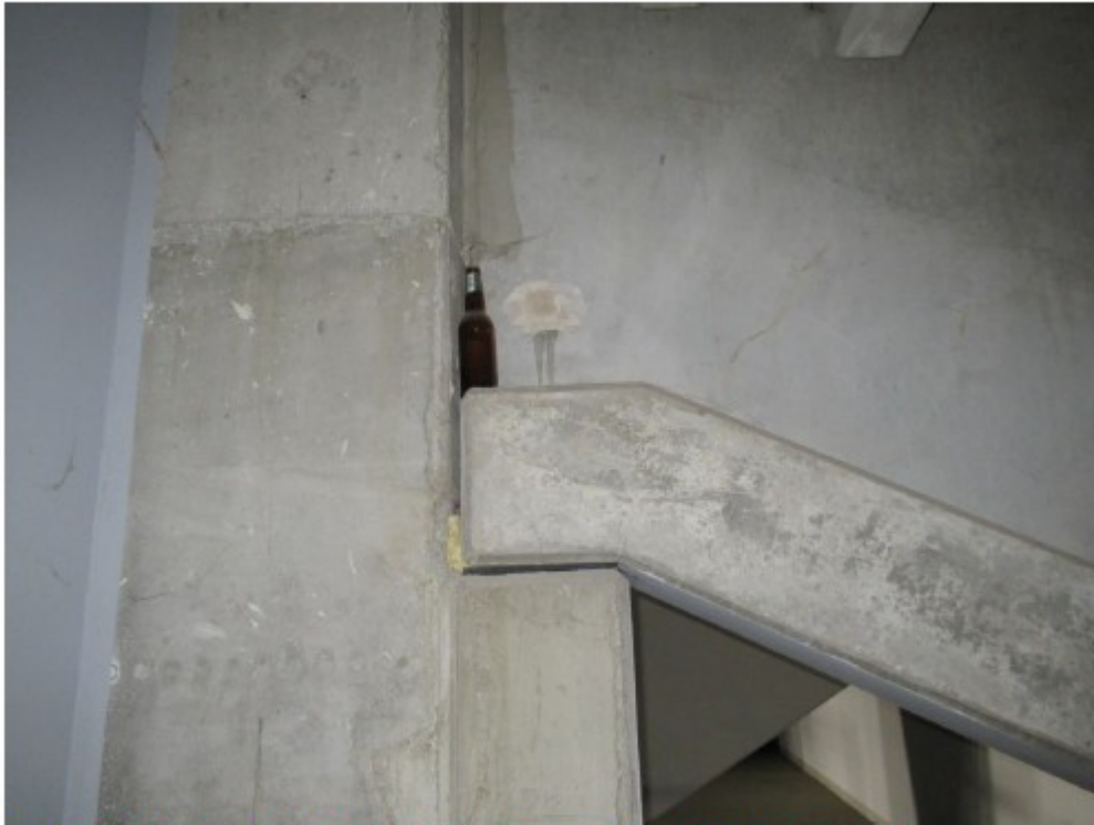
Fot. 36 - 2018 r. - nie stwierdzono poszerzenia rysy. Zalecana dalsza obserwacja.
