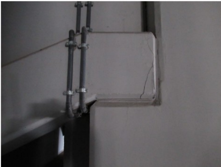
Fot. 30 - 2018 r. - nie stwierdzono poszerzenia rysy. Zalecana dalsza obserwacja.
