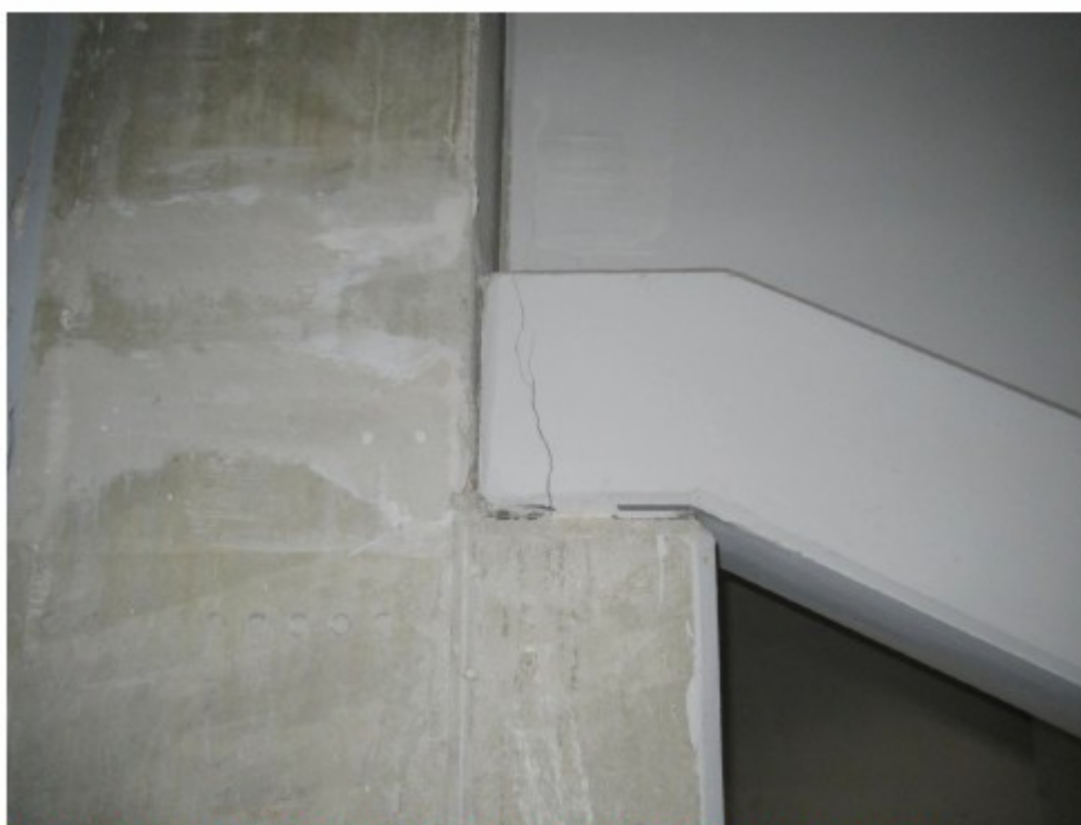
Fot. 34 - 2018 r. - nie stwierdzono dalszego poszerzenia rysy. Zalecana obserwacja
