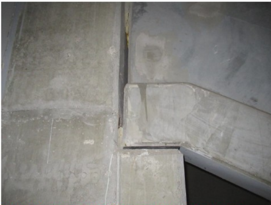
Fot 23 - 2018 r. - nie stwierdzono powiększenia rysy - zalecenie: dalsza obserwacja
