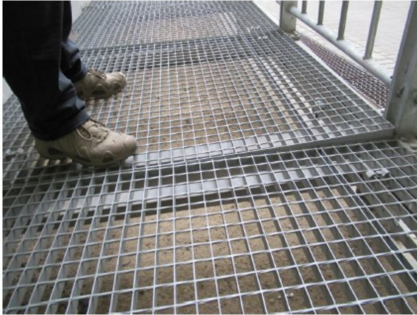
Fot. 47 - 2018 r. - zagięte kraty typu "Wema" na rampie.
