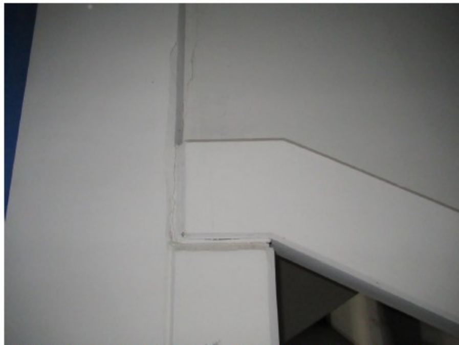
Fot. 38 - 2018 r. - nie stwierdzono poszerzenia rysy. Zalecana dalsza obserwacja.
